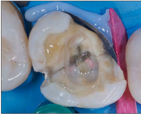
Figura 7. Elevación de margen profundo con sistema de matriz SlickBands de Garrison.
